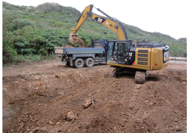
写真7 重機による表土掘削作業風景
