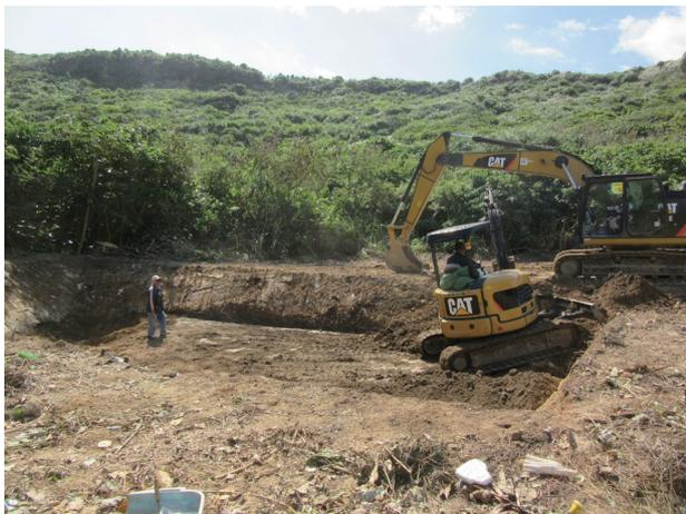
写真8 重機による表土掘削作業風景
